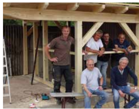
Bau der Stockschützen-Hütte in Eigenleistung
